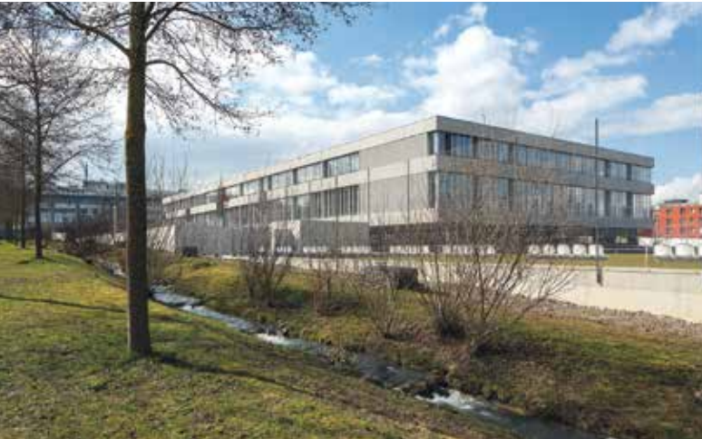
ABBILDUNG 6: Schulanlage Blumenfeld (Foto: Amt für Hochbauten Stadt Zürich).
